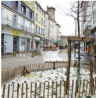
rénovation de pavés
