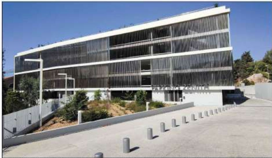
Prêt depuis quelques semaines, le parking du Zénith va héberger 660 places sur cinq niveaux.
