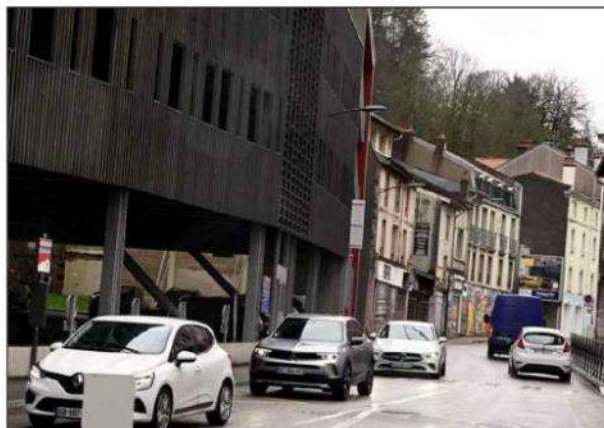
Les bâtiments qui s'élèvent entre le parking Saint-Michel et celui de la carrière Desbuissons vont être démolis pour procéder à l'extension. Photo VM/Eric THIEBAUT
