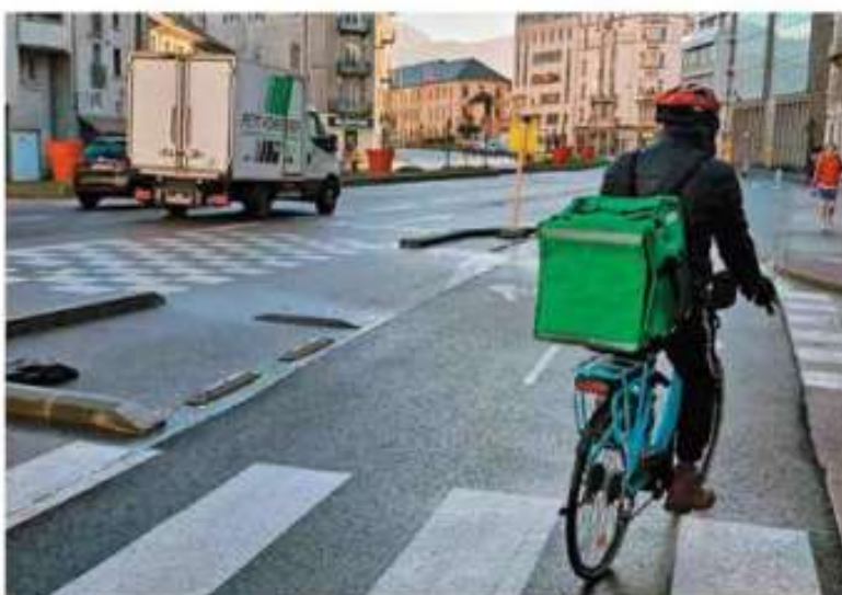
... et après les travaux.
