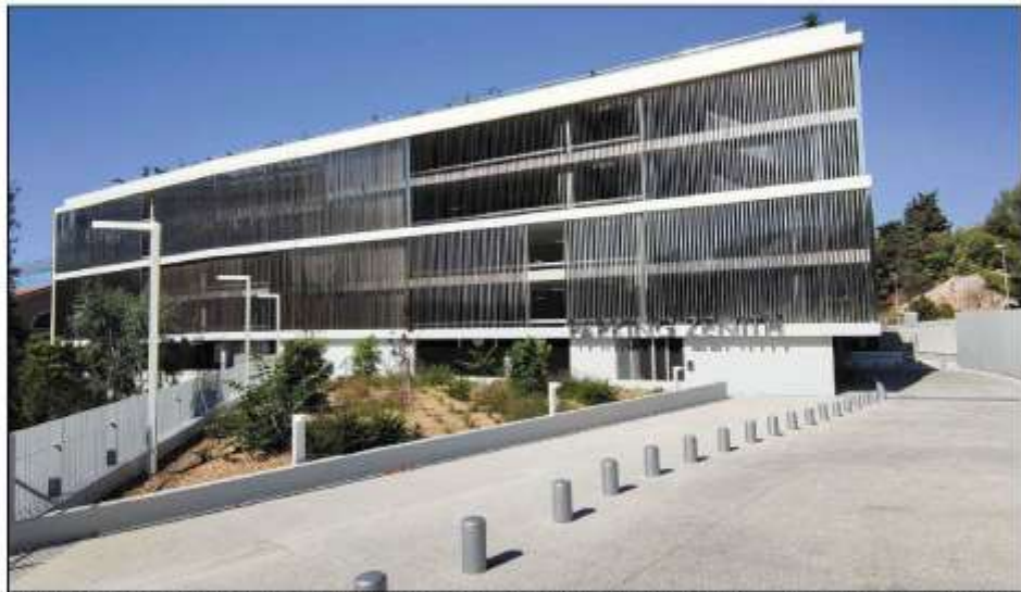
Prêt depuis quelques semaines, le parking du Zénith va héberger 660 places sur cinq niveaux.
