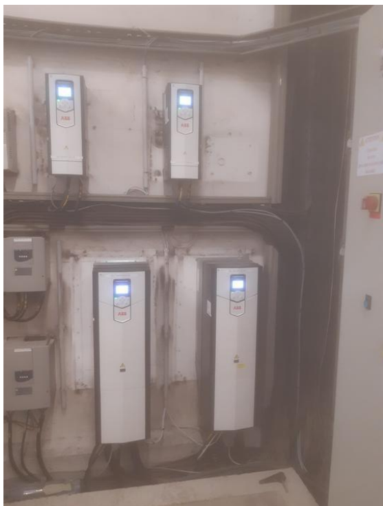
Variateurs et AddiQ (superviseur) centrifugeuse 2
