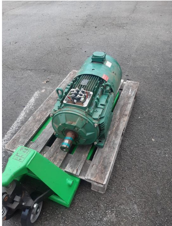
Réfection moteur surpresseur aération n°4
