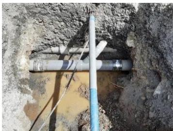
Impasse DE LA GAIETE : 2 réparations réseau (PVC cassé et fissuré) + découpe d'un PVC (branchement pénétrant)
