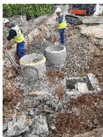
I GENERAL DE GISSAC : Réparation réseau PVC 200 + réparation branchement + réparation branchement suite à des racines
