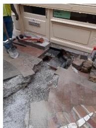
7 AV DE LA REPUBLIQUE : Colmater bâti fuyard, Béton couler au contour d'une plaque en fer qui sert de toit du bâti (travaux à l'aspiratrice)
