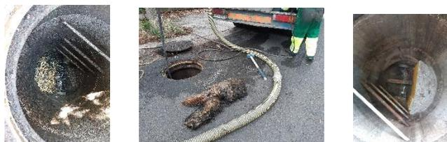
DO ECRETEUR STEP + DO ECRETEUR DES ONDES (CH BORD DU TARN) : mise en place disque d'étalonnage + cornière d'étalonnage
